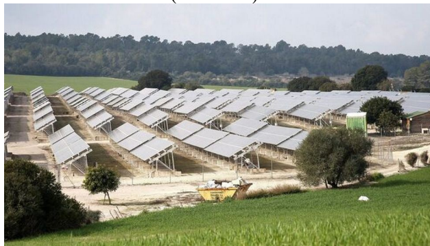
Parc fotovoltaic a Porreres.
