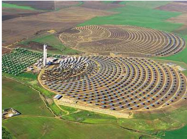
Central de Sanlúcar (Sevilla)
